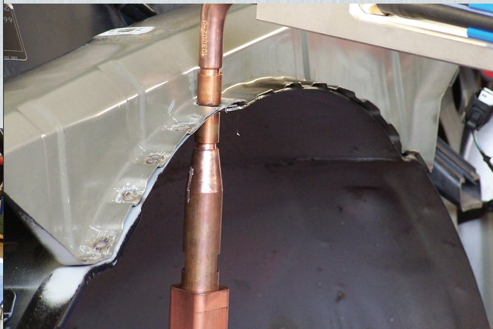
STANICE PRO DOVAŘOVACÍ PRÁCE - ROBOTOVÁ LINKA
